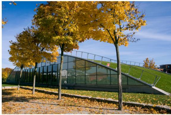
Gymnase semi-enterré Quartier durable de Rieselfeld
